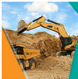
Travaux de terrassement
